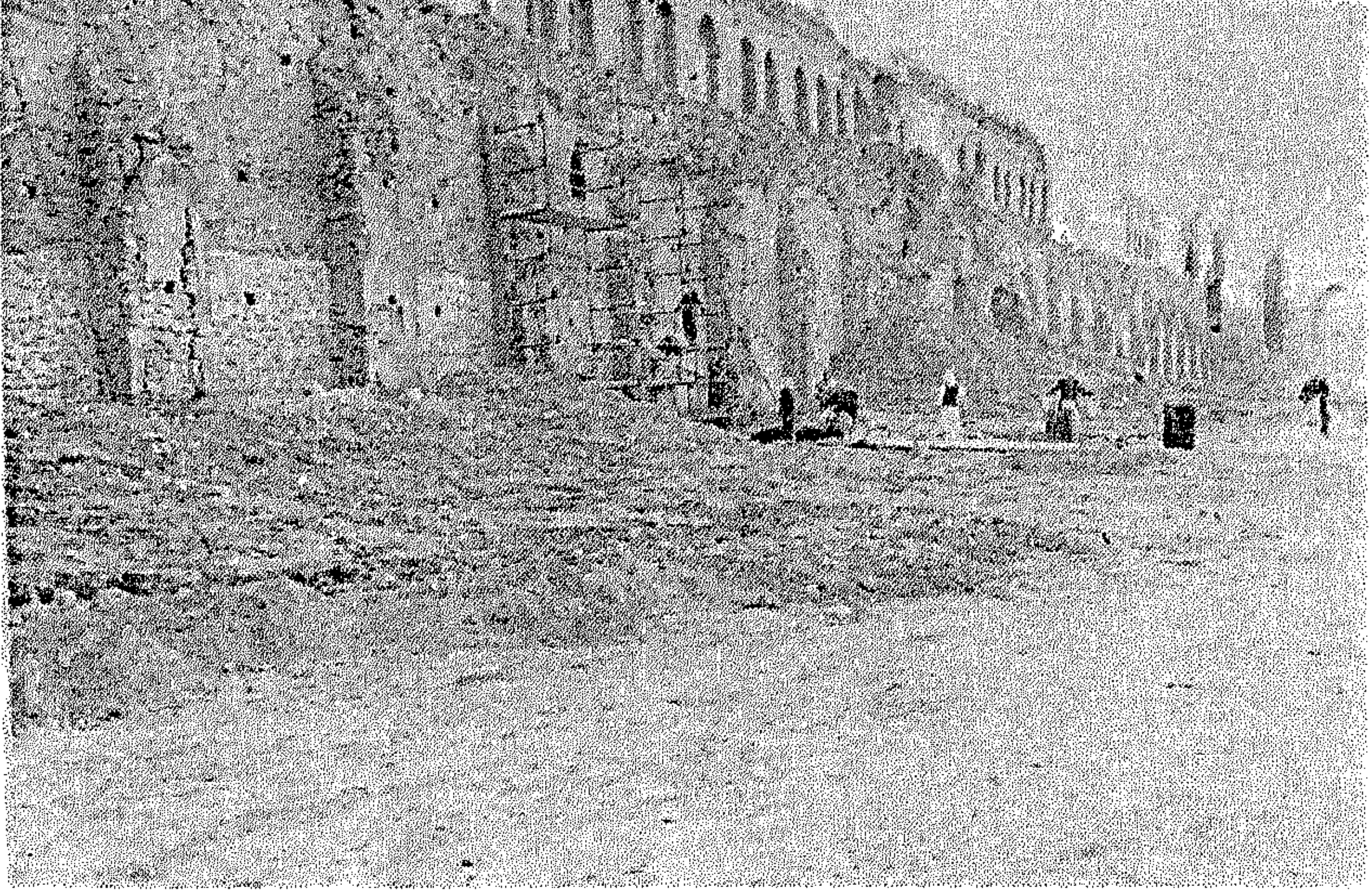
صورة رقم ٣ - أنقاض السور الجنوبي من الداخل
