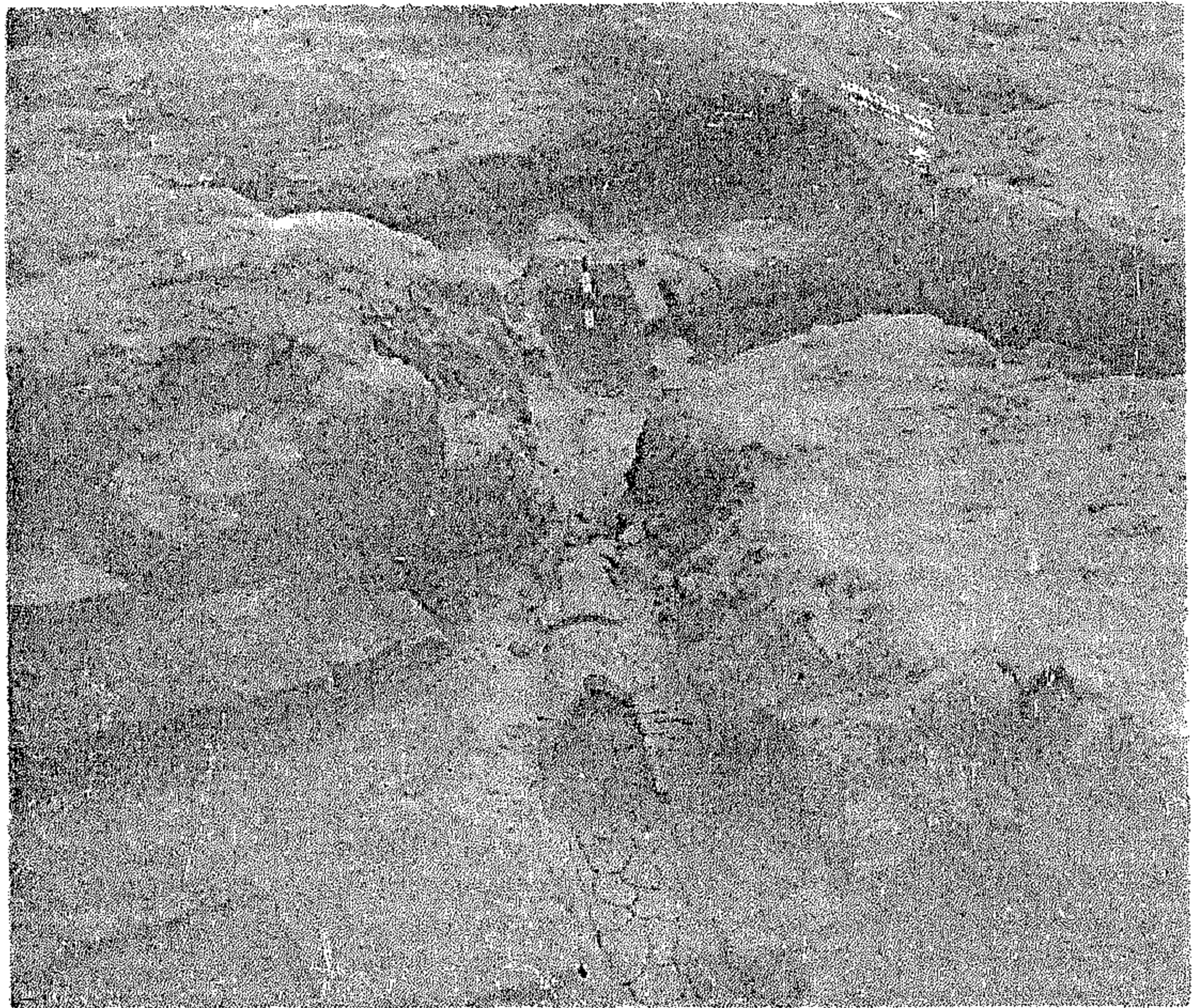
ب - مجرى الماء المكون من سلسلة من الاسطوانات الفخارية المتداخلة . B. Drain composed of a series of pottery cylindrical pipes
