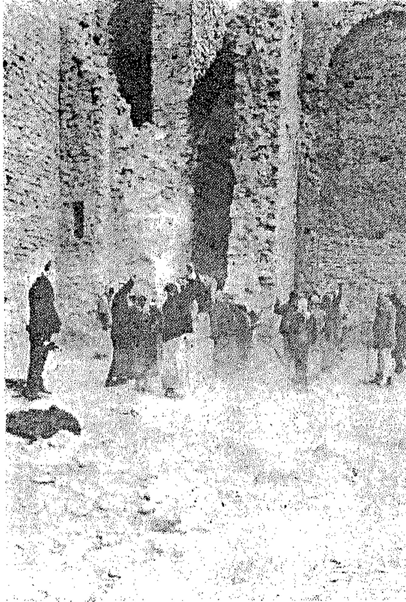
صورة رقم ١٨ - عمليات رفع الانقاض برج الزاوية الجنوبية الشرقية
