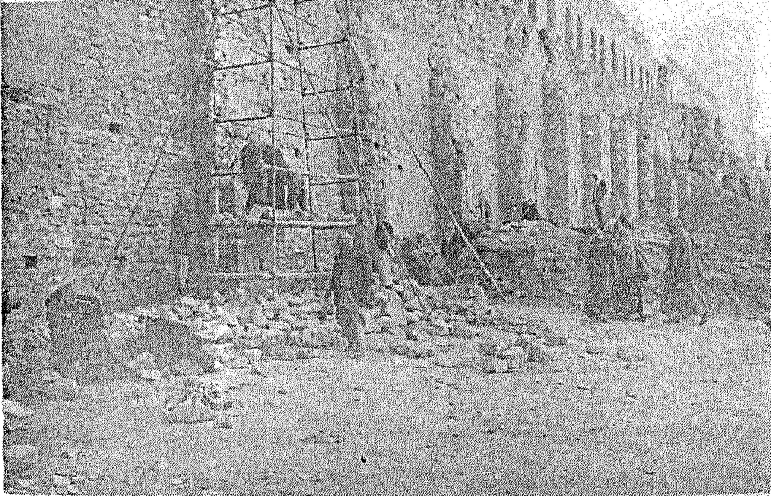
صورة رقم ٤ - أنقاض السور الجنوبي من الداخل
